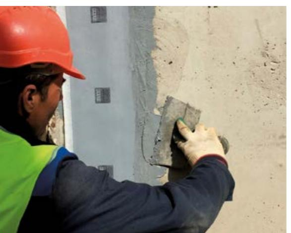
Перехлест эластичных лент в зоне стыковки должен быть не менее 40 мм.
